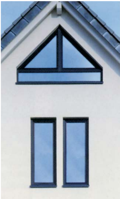
Rechteckige, hochstehende Fenster ohne Sprossenteilung betonen die Vertikale und optimieren zusätzlich den Lichteinfall.
